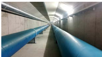
infraestructura de agua
